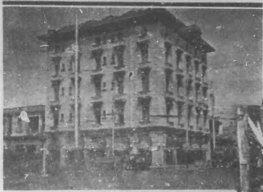
EL NIDO DE LA TIFOIDEA —El edificio "Fonollar" de Doce y Veintitrés en el Vedado, cuyos habitantes, en número mayor de treinta se encuentran atacados de Tifoidea. Según investigaciones realizadas, la contaminación de las aguas del edificio, ha provocado la epidemia que ya ha costado la vida a uno de los habitantes
